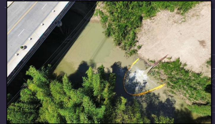
Descarga al río del Dique C (By-pass)
