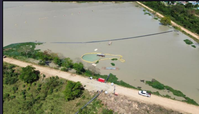
Vertedor del Dique C
