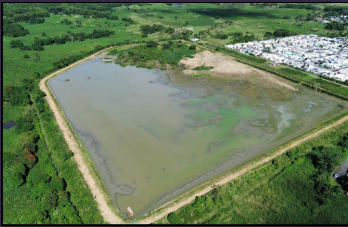
Dique A – Vista Aérea
